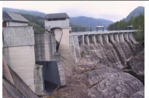
Grønvollfoss dam – venstre del nedenfra
