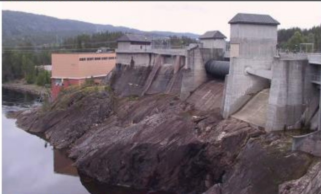
Grønvollfoss dam - høyre del nedenfra
