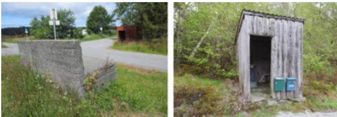
T.v. støypt mjølkerampe og «blekkskur», Bjelland. T.h. leskur, Selsås.
