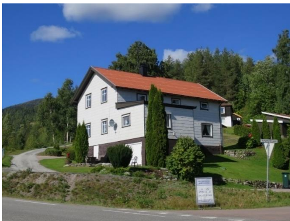
De tidligere handelslokalene Eggedalsveien 1509 er nå tatt i bruk som bolig. Bygningen ble opprinnelig oppført som skole på Båsum i 1864. Bak den sekundære eternittkledningen skjuler seg den gamle tømmerkonstruksjonen.
