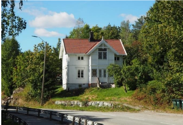
2-etasjes bolig i Eggedalsveien 1523. Tomten ble utskilt fra Hovland (gnr. 148) i 1925 og bebygget straks deretter.
