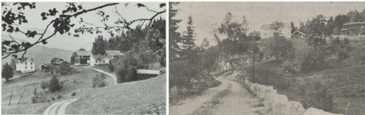
Pletan (149/1) fotografert fra øst ca. 1940. Bildet til høyre viser tunet med våningshuset sett fra Eggedalsveien, den gang Nyveien, i 1928. Her står en gruppe eldre bygninger, herunder våningshuset på sydsiden av tunet som er antatt bygd på midten av 1600-tallet, men påbygd med en etasje på 1900-tallet. Bilde: Norske gardsbruk (1948) / Fremtiden 02.02.1929
