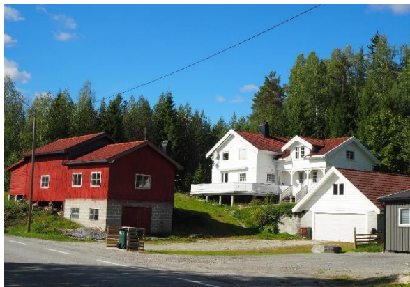
Bolig i Eggedalsveien 1533, med garasjer og uthus fra flere epoker. Bolighuset og det røde uthuset sto ferdig i 1949 og ble bygget av Knut Jellum, som fra da var klokker i Eggedal. Sidefløyen med ark er senere. Skilt ut fra Hovland (gnr. 148).
