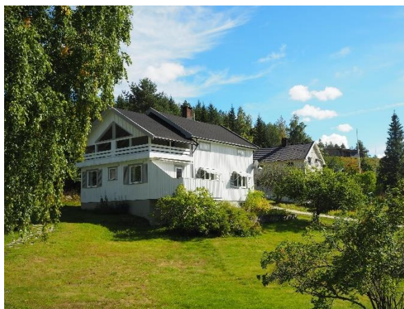
Utvidete 1½-etasjesbolig i veien Teige nr. 12, utskilt fra Nedre Teige (gnr. 147) og bygget i 1952.
