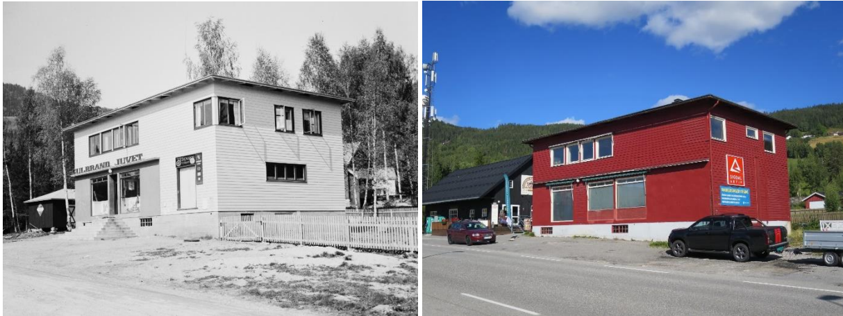
Gulbrand Juvets forretning, Eggedal sentrum 1939 og bygningen i dag. «Bua» i bakkant ble oppført ca. 1950. Bilde: Nasjonalbiblioteket
