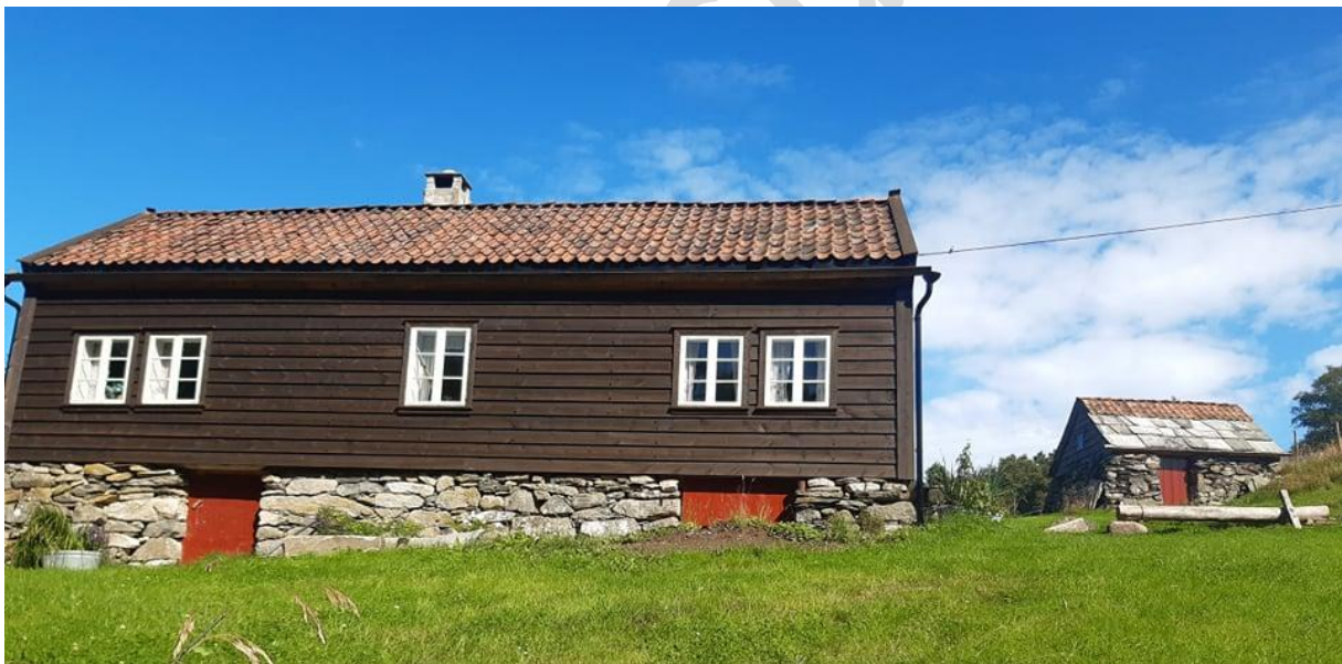
«Bentahuset» på Mølstre, med eldhus, etter restaurering. Også løa og sauehuset er restaurert.
