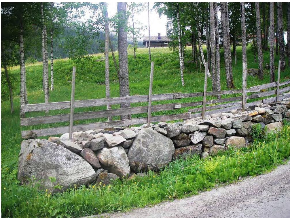
Steingard med bordgard på. Restaurert i samband med kurs. Foto: Ingvill Garnås.
