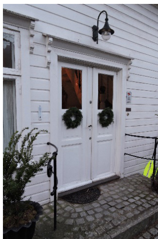
Opprinnelig tofløyet dør.
