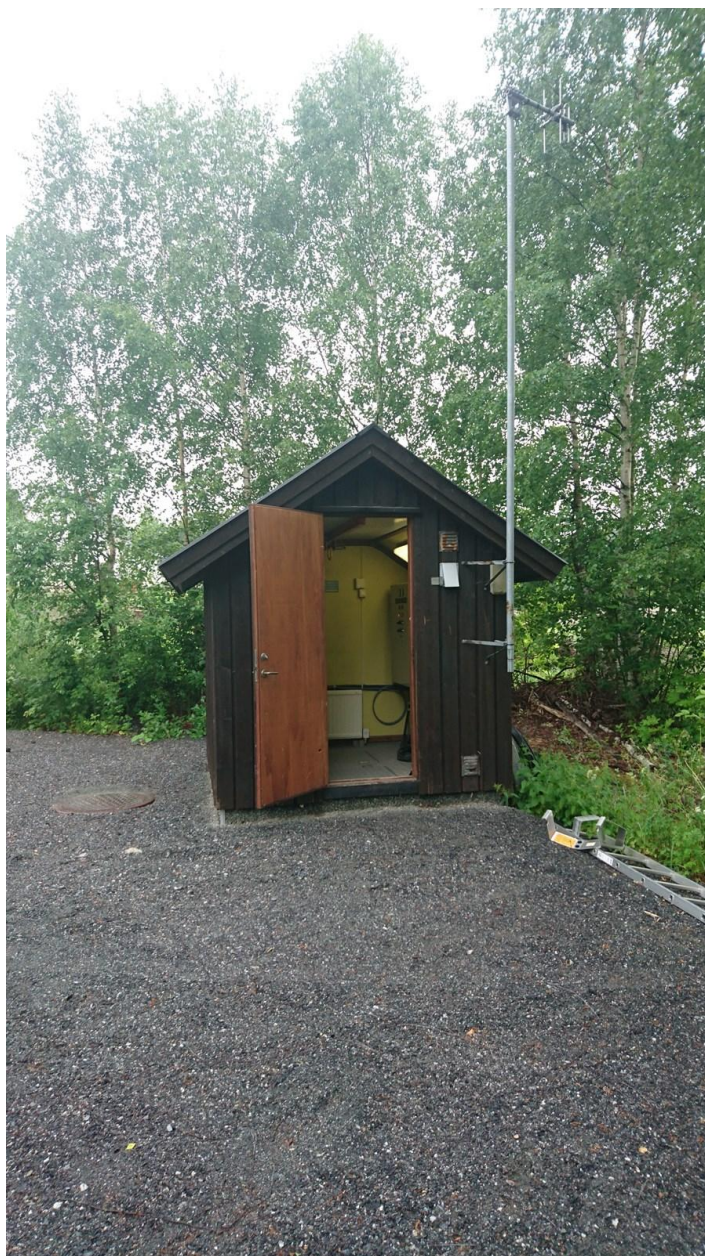
Bilde: Pumpestasjon P06 – Sunnegrenda
