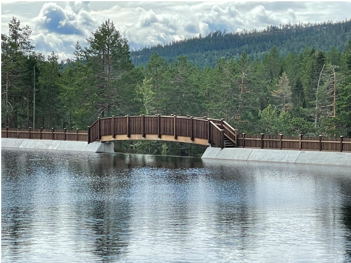
Bilde: Damanlegg Tangentjern
