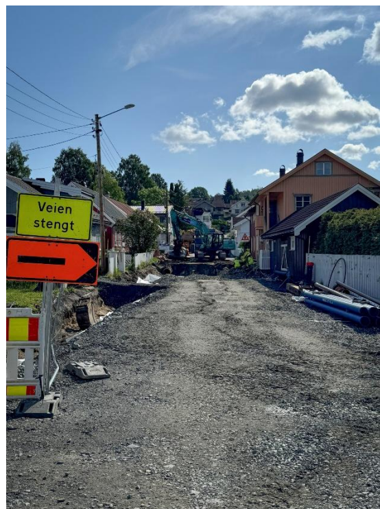
Bilde: Fornyelse av ledningsnett i Eikerveien.
