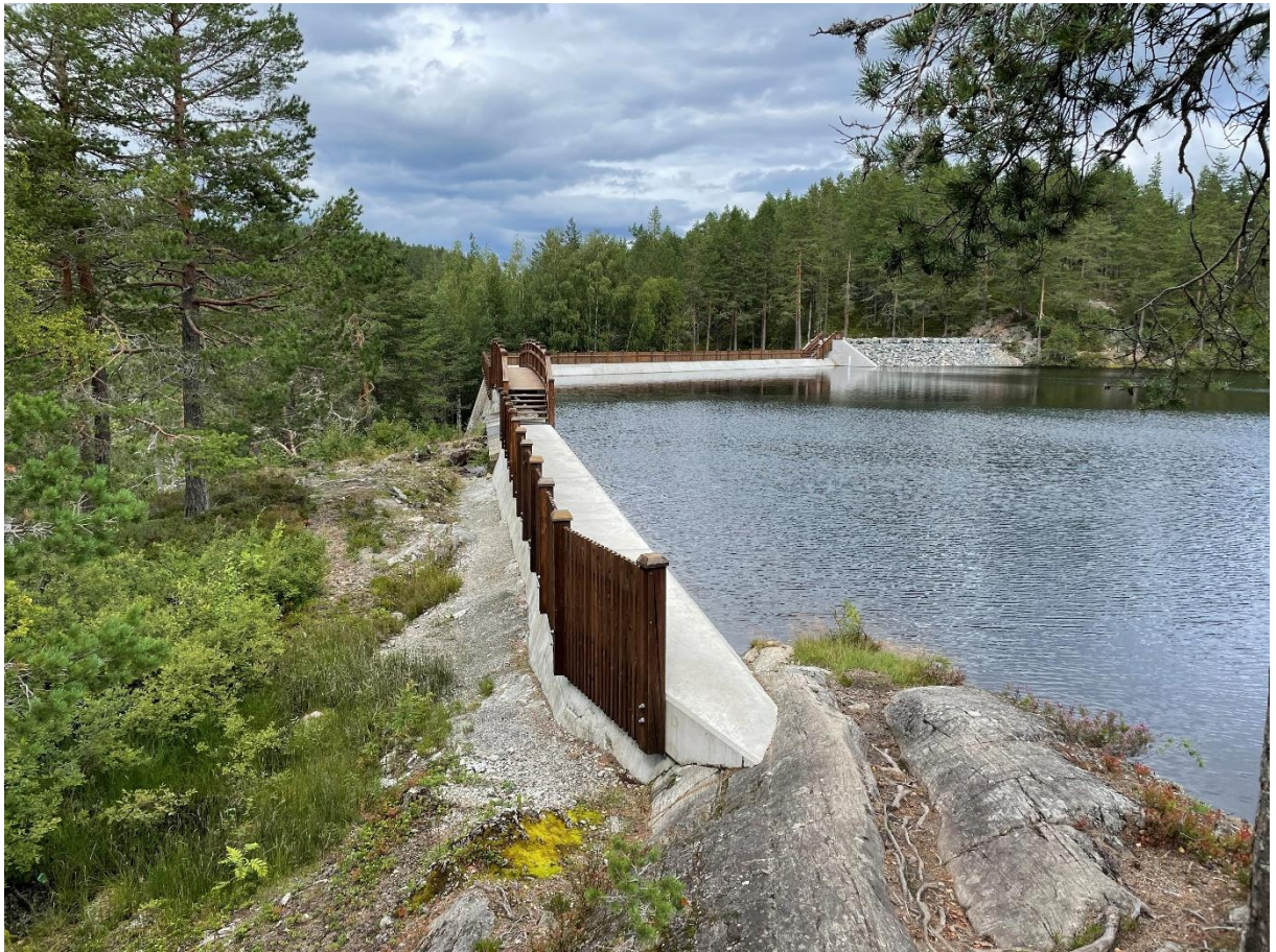
Bilde: Damanlegg Tangentjern.
