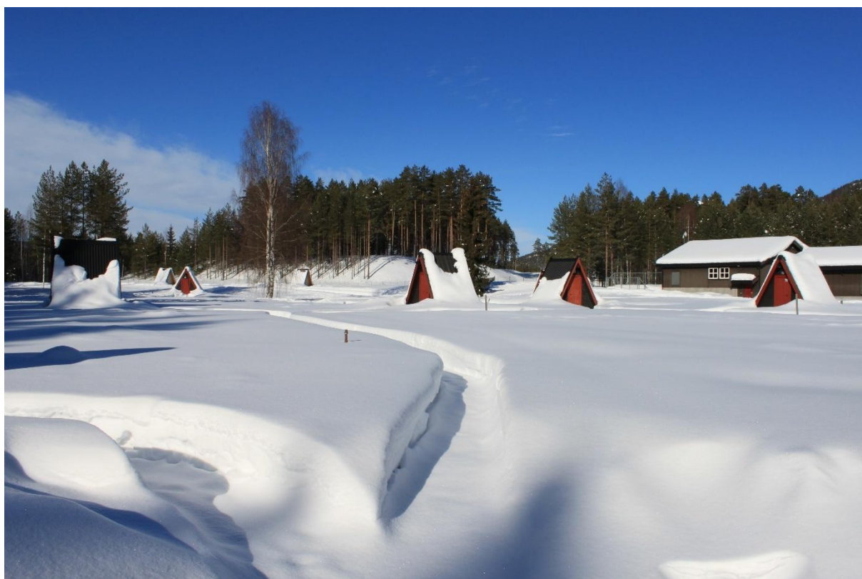
Bilde: Bevertangen vannbehandlingsanlegg.
