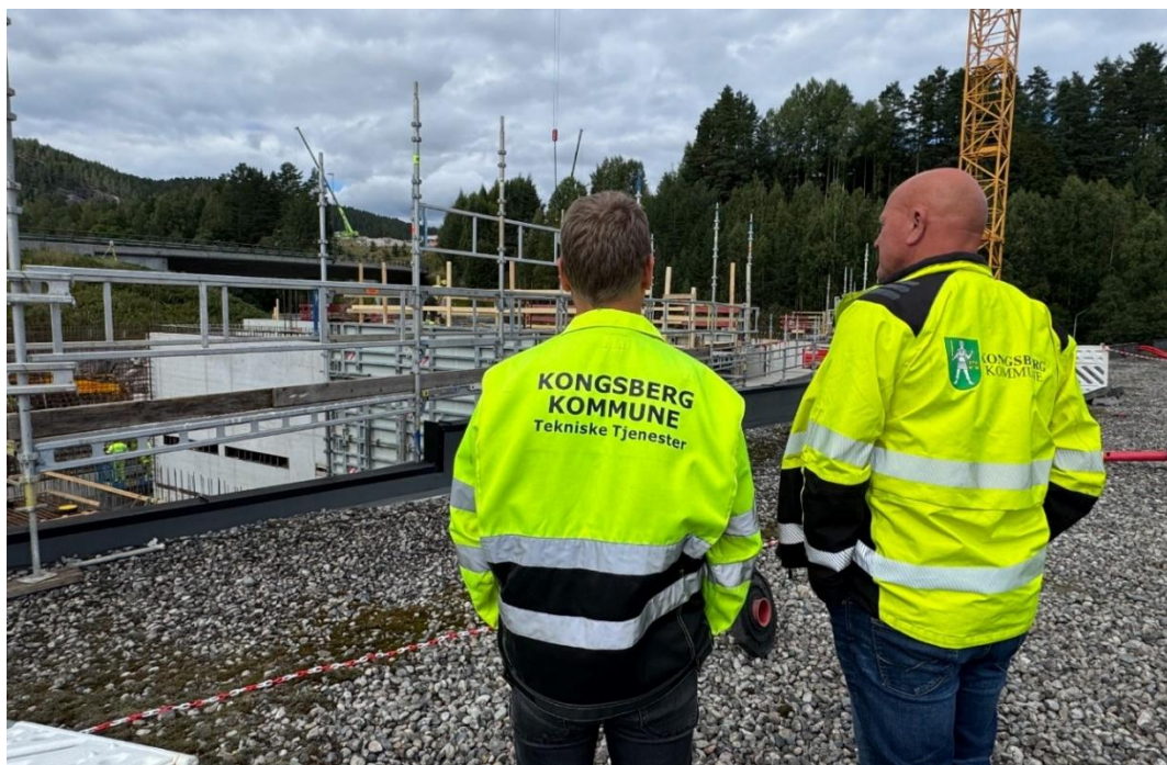
Bilde: Bygging av nye Kongsberg renseanlegg.
