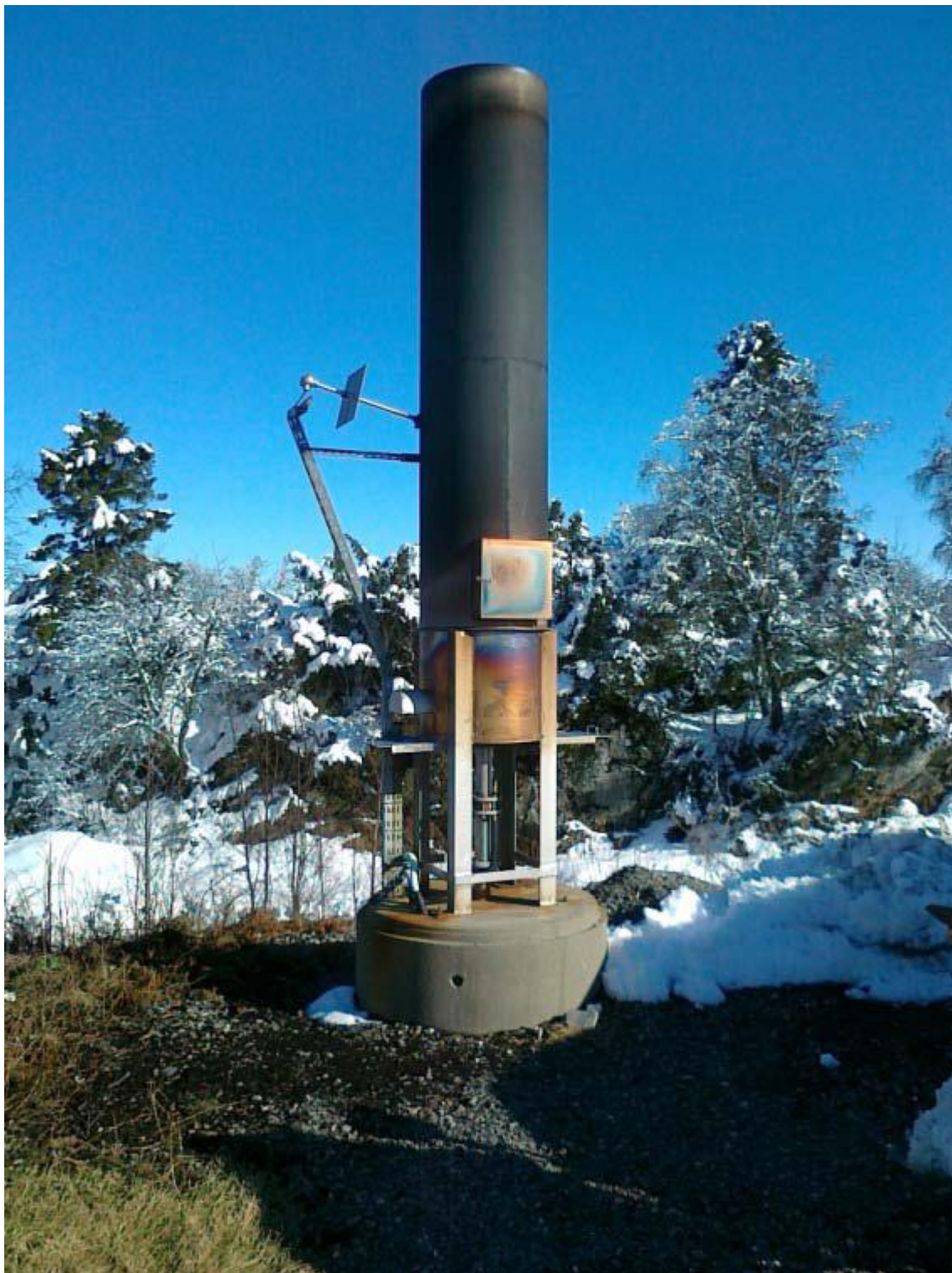
Figur 14: Fakling av metangass - Mjeldstad deponi (fotoeigar Liquiline)
