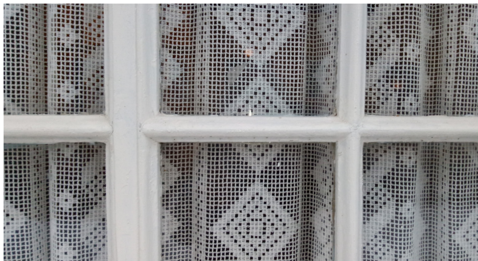
Detalj som viser utførelse av sprosser i opprinnelig inngangsdør. Foto: Ingrid Kvissel/Sør Arkitekter
