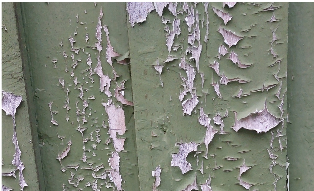
Eksempel på flassing. Foto: Ingrid Kvissel/Sør Arkitekter
