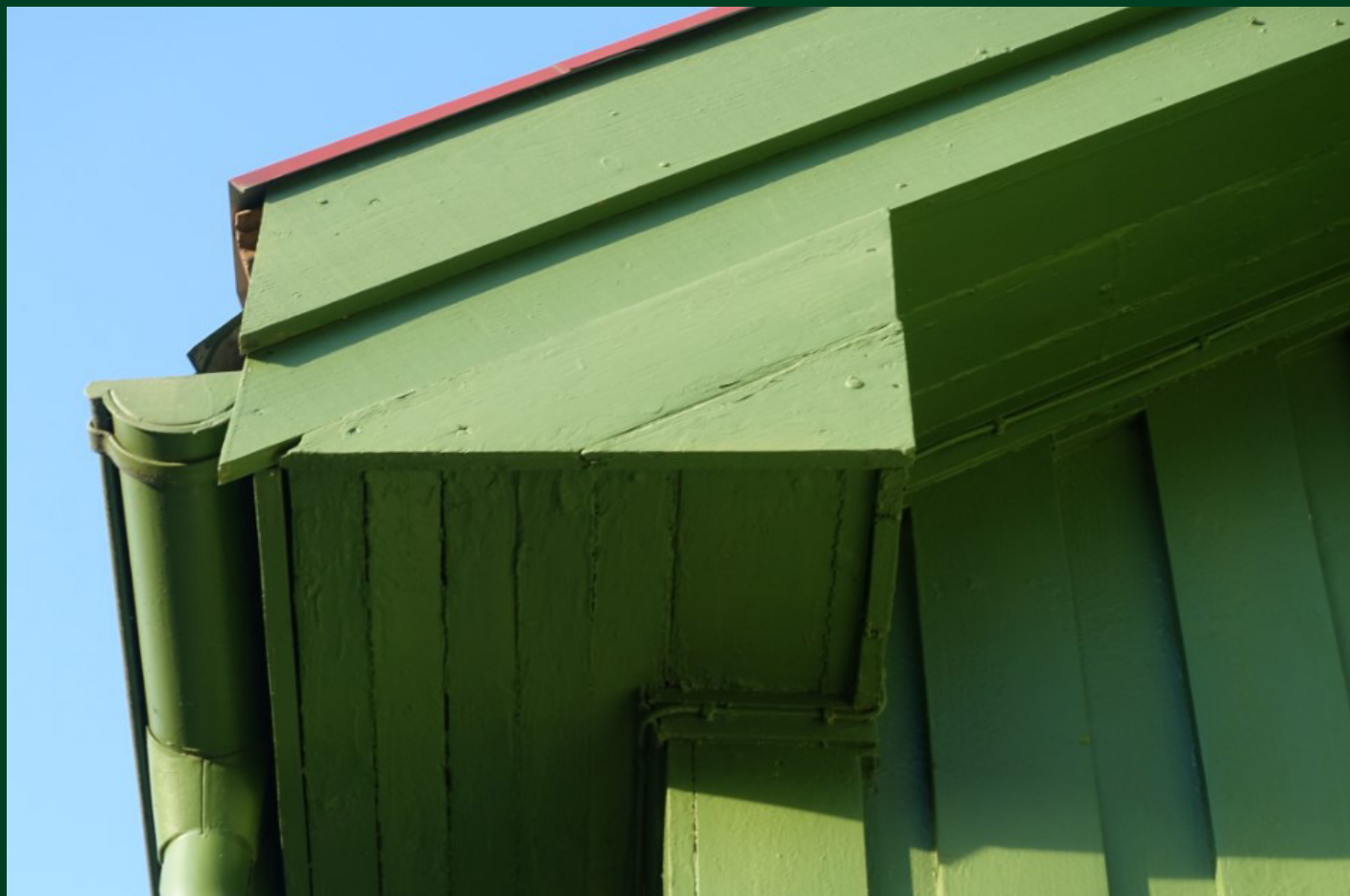
Eksempel på vindskibord fra Grønnbyen. Foto: Ingrid Kvissel/Sør Arkitekter
