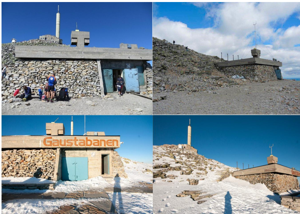
Fig. 11: Utgangen fra Gaustabanen på Tuddalstippen. Øvre bilderad er fra før 2010, nedre rad viser dagens situasjon.
